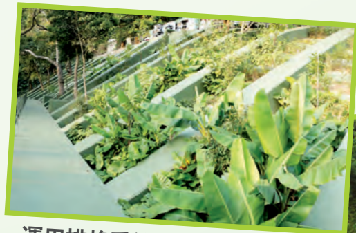
運用排格系統保留斜坡上的現存植物。
