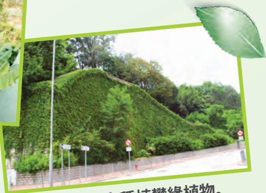
運用排格系統保留斜坡上的現存植物。
