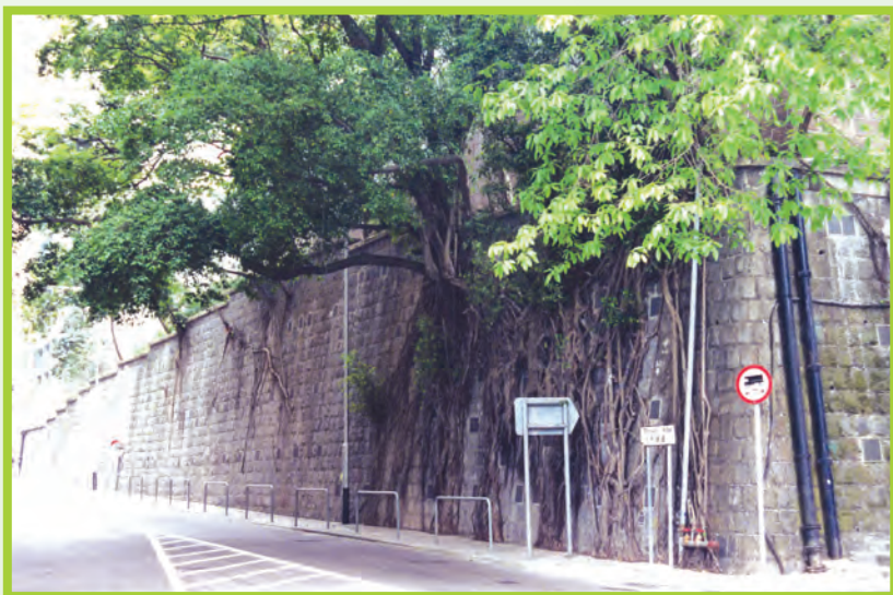
使用泥釘鞏固擋土牆，可保留牆上的樹木。
